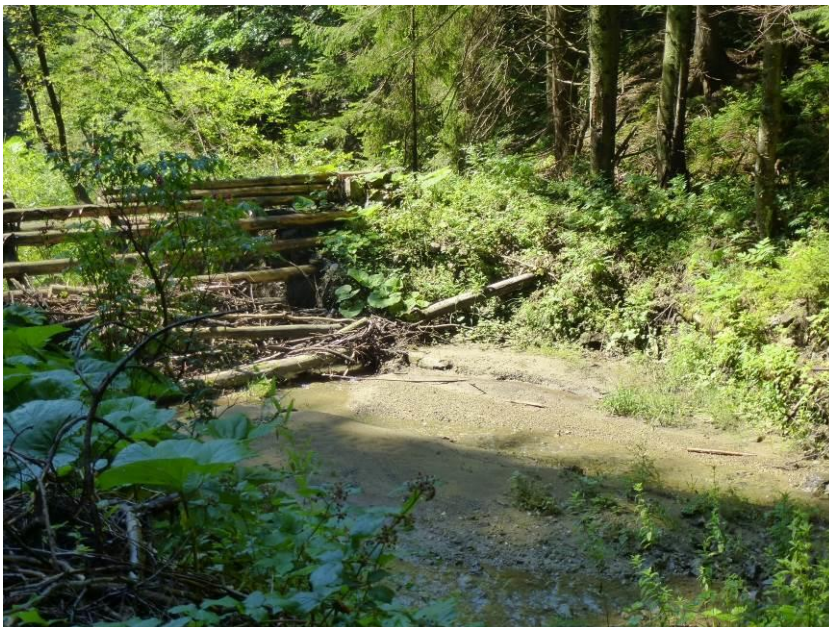
Obrázok 10 Čiastočne zanesený lapač splavenín na toku Riečka (foto: Kaletová)
