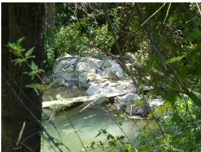
Obrázok 5 Jedna z poškodených prehrádzok na toku Rozdiel (foto: Kaletová)
