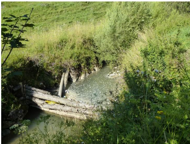
Obrázok 5 Jedna z poškodených prehrádzok na toku Rozdiel (foto: Kaletová)
